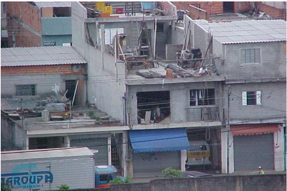
Foto 3 – Jovem na “beira da laje”
